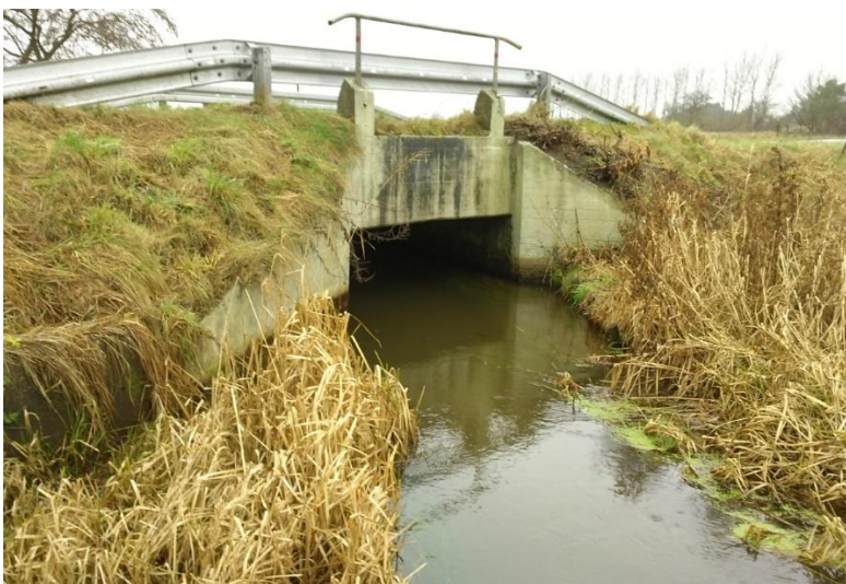
Vejunderføringen ved Vallerbækvej
